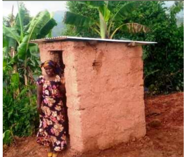
Toilette NYIRAMANA Triphine de Samiyonga après la réhabilitation
