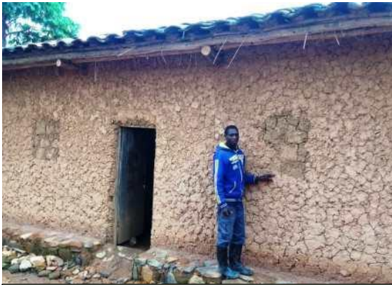
Maison de NIHOREHO Bosco de Ruhinga avant le crépissage
